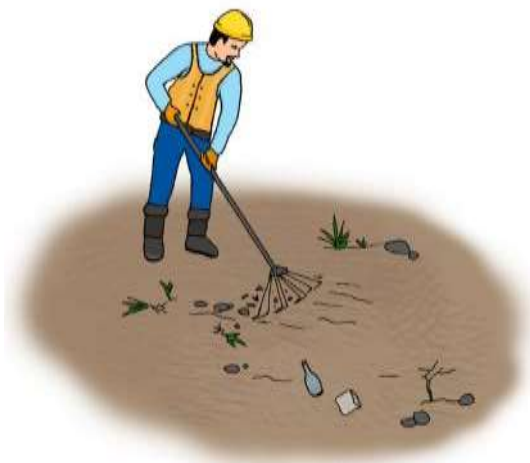
Figura 23: Limpieza del terreno
