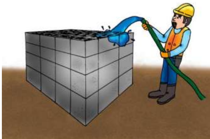
Figura 59: Humedecimiento de bloques
