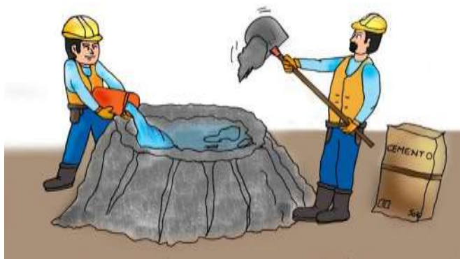
Figura 60: Preparación del mortero
