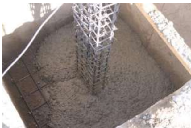
Figura 42: Fundición de plintos.
