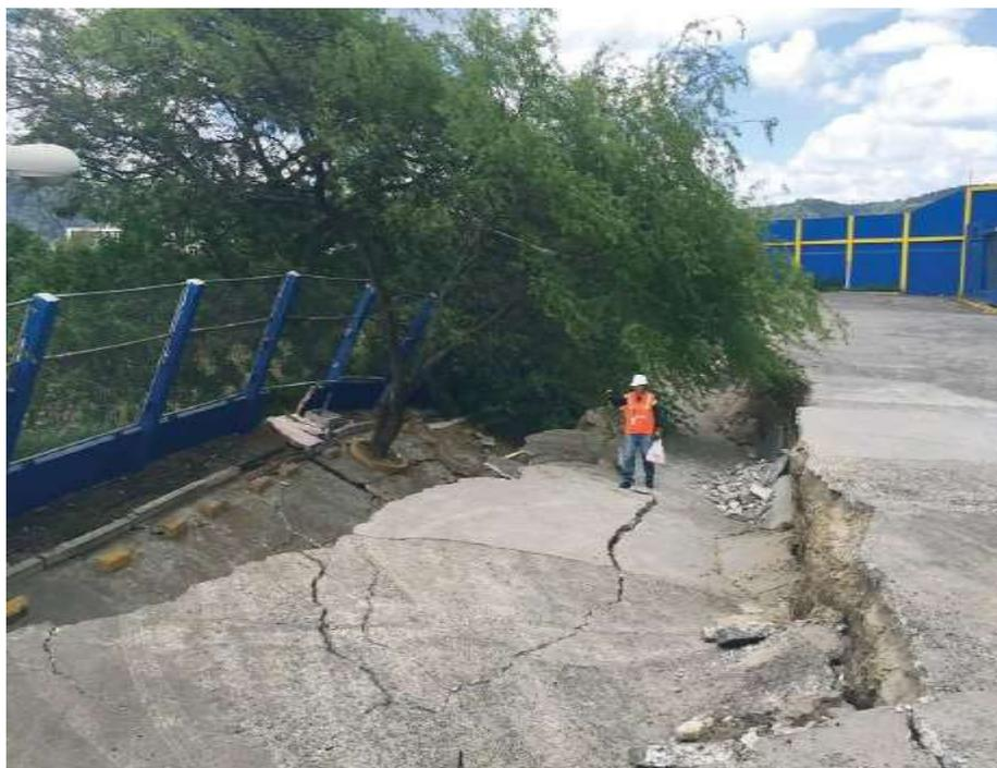
Figura 189: Colapso en veredas producto del movimiento del suelo. Manabí, Ecuador, 2016
