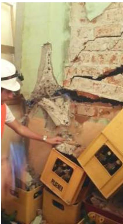
Figura 175: **Daño severo en columnas, grietas grandes en pared de ladrillo. Terremoto de Pedernales, Ecuador 2016.**
