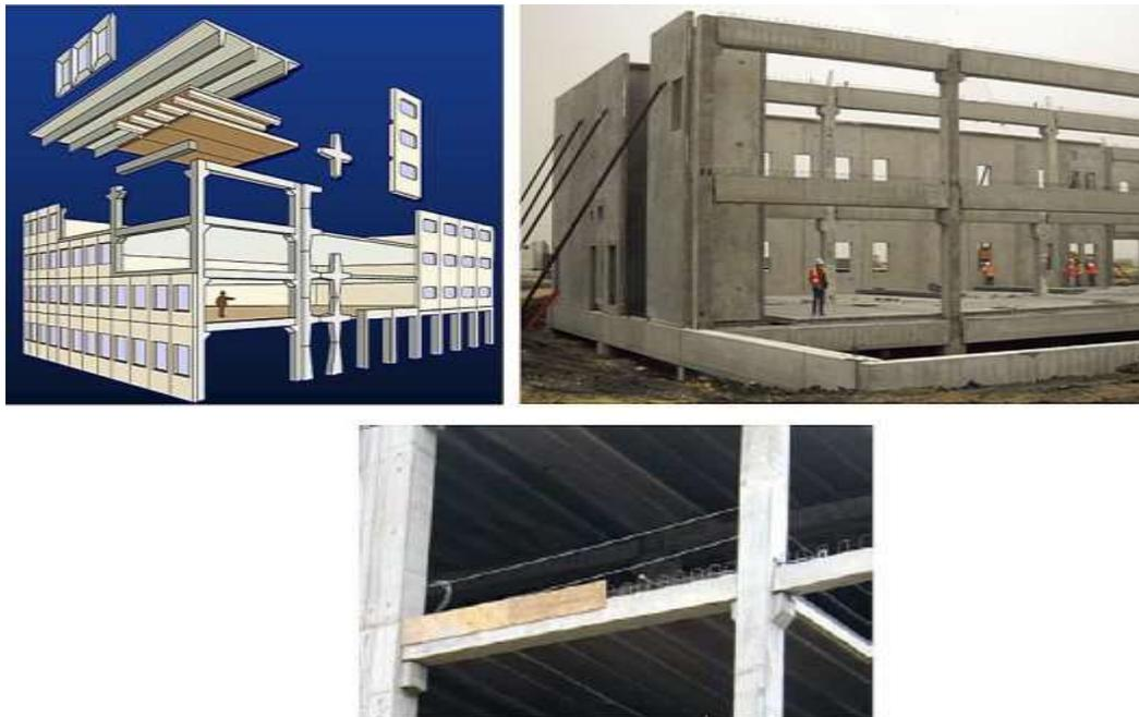
Figura 120: Tipo de sistema estructural: Hormigón armado prefabricado (PC).
