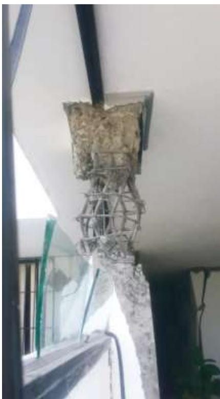
Figura 176: **Daño severo en columnas, efecto de torsión. Terremoto de Pedernales, Ecuador 2016.**
