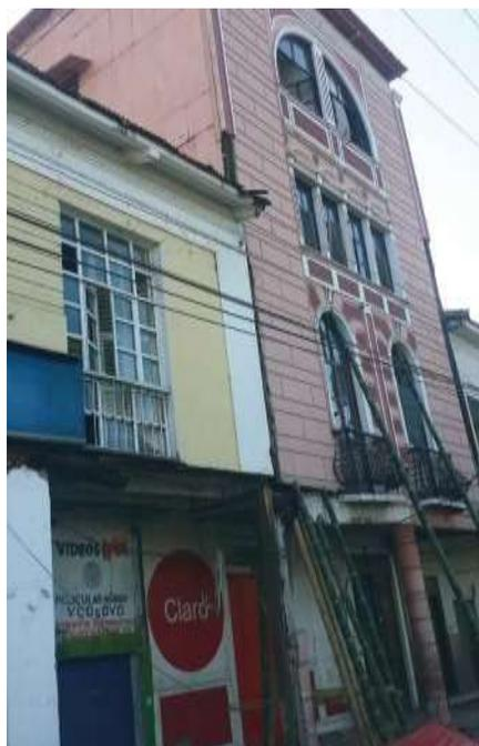
Figura 172: **Edificación fuera de aplomo, se puede observar apuntalamiento por seguridad. Bahía, Ecuador 2016.**
