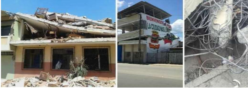
Figura 24: **Losas planas con vigas banda. Fallos por punzonamiento**
