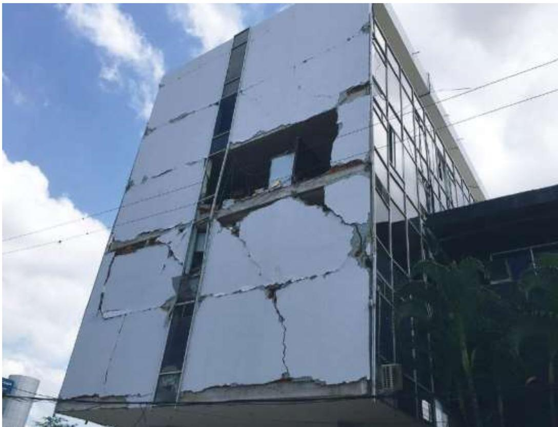
Figura 177: Grietas grandes en paredes u otros daños severos. Señalizar Inseguro. Terremoto de Pedernales, Ecuador 2016.
