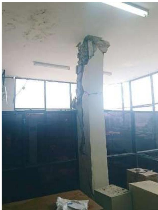
Figura 174: **Daños severos en columna interna. Terremoto de Pedernales, Ecuador 2016.**
