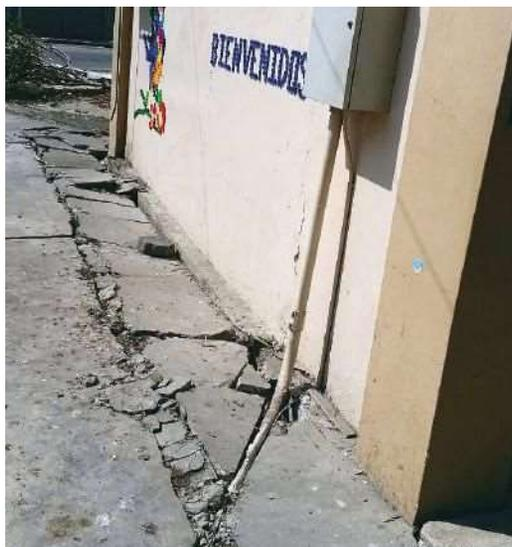
Figura 33: **Vista de una escuela con un asentamiento, luego del sismo del 16 de abril de 2016 en Manta, Ecuador.**
