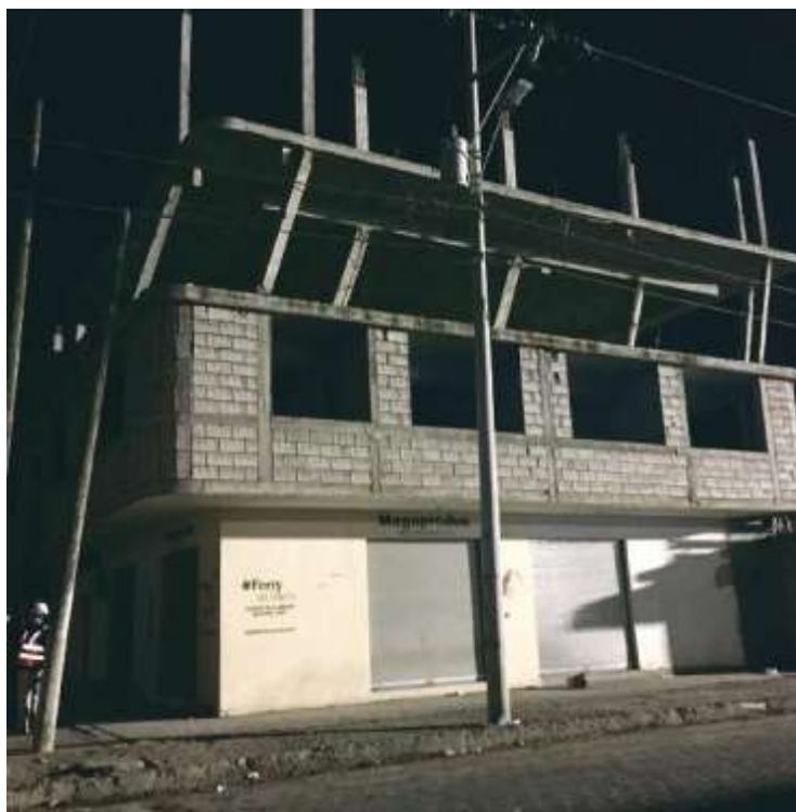
Figura 168: **Edificación fuera de aplomo. Terremoto de Pedernales, Ecuador 2016.**
