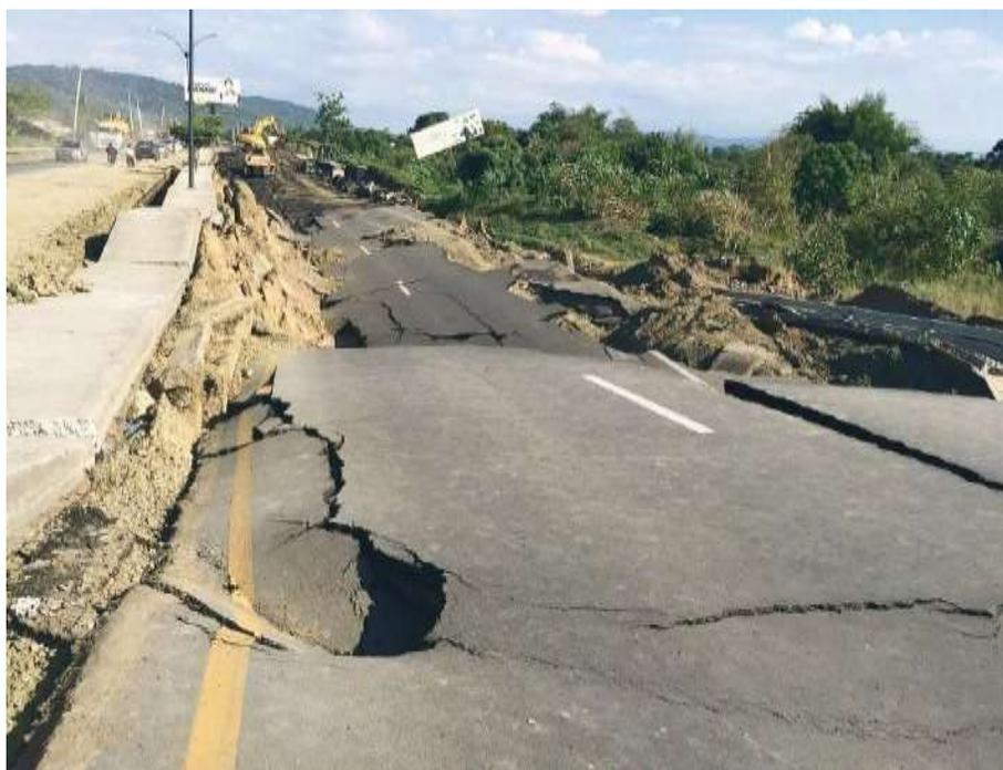
Figura 186: **Hundimiento de la calzada producido por movimiento del suelo. Manabí, Ecuador, 2016**
