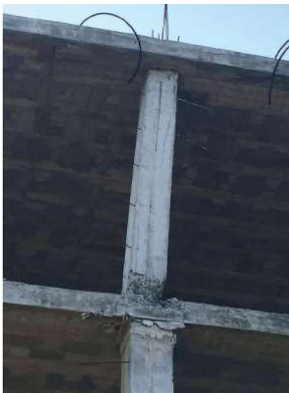
Figura 171: **Edificación fuera de aplomo. Terremoto de Pedernales, Ecuador 2016.**
