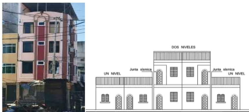
Figura 5: Calidad de suelo y diferencia de niveles: juntas de construcción
