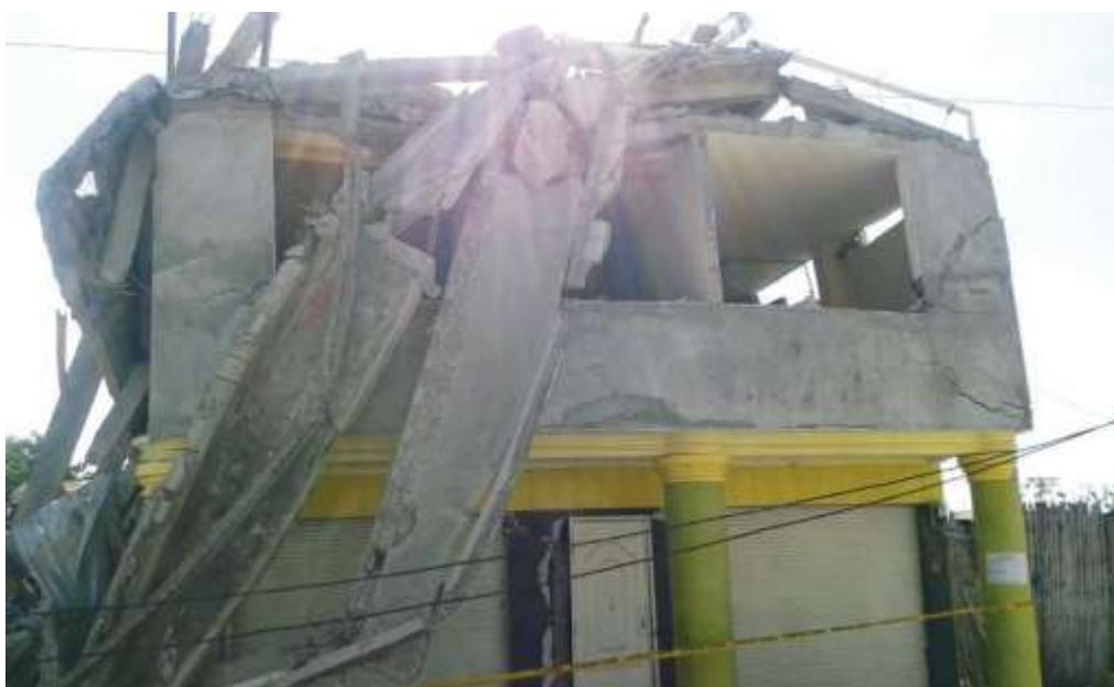
Figura 164: **Colapso total de la estructura. Terremoto de Pedernales, Ecuador 2016.**
