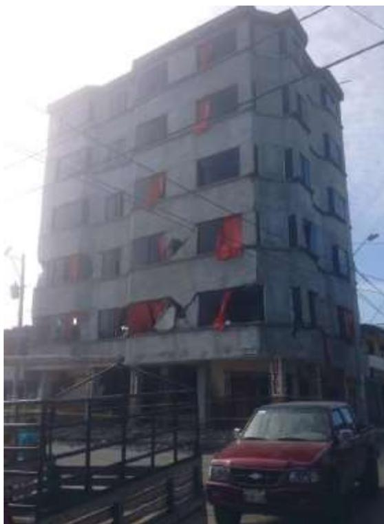
Figura 185: **Revestimientos y mamposterías amenazan caer. Terremoto de Pedernales, Ecuador 2016.**
